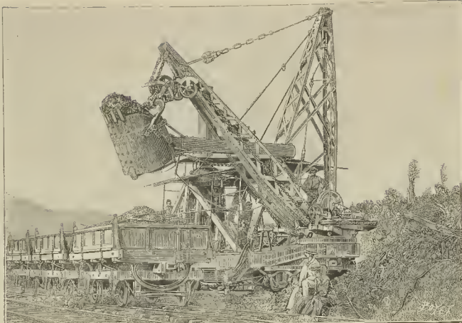
Fig. 1.—TRABAJOS DE PERFORACION DEL ISTMO DE PANAMÁ.—El excavador Osgood en la zanja grande la Culebra
